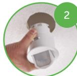
2 Вставьте датчик в отверстие, отогнув зажимные механизмы крепления.
